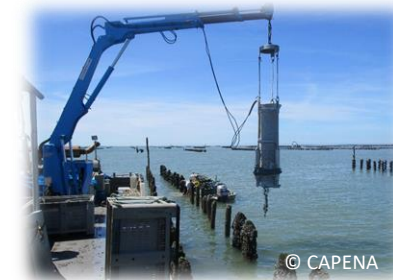
Grue et matériel hydraulique sur bateau atelier mytilicole
